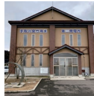
だいに はつでんしょう 小水発電 第二発電所(宮竹町)
